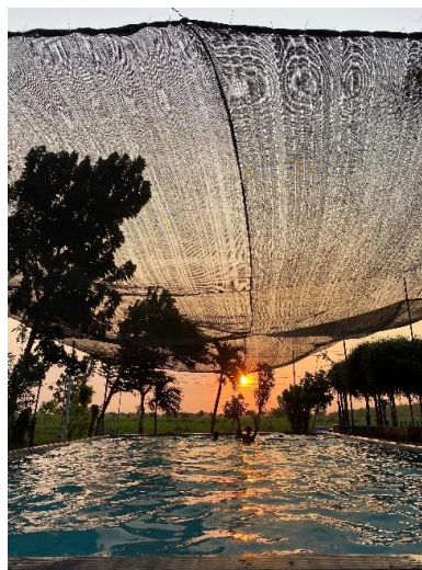
Gambar 2. Area kolam renang setelah dibangun fasilitas paranet
